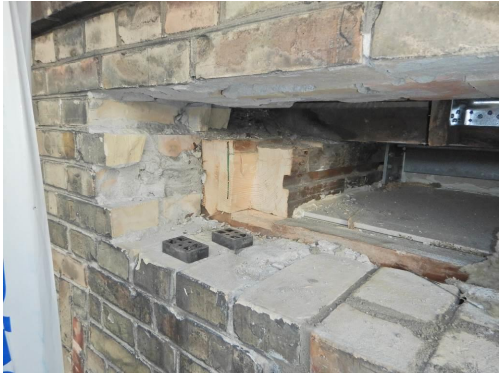
Foto 9: 3. sal. Der kunne ikke ses tegn på nedbrydning i enden af bjælke B3.6 og underliggende bjælkerem.
