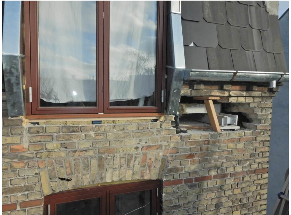
Foto 5: 3. sal. Åbning i ydervæg ind til enden af bjælke B3.1 og B3.2, samt underliggende bjælkerem.
