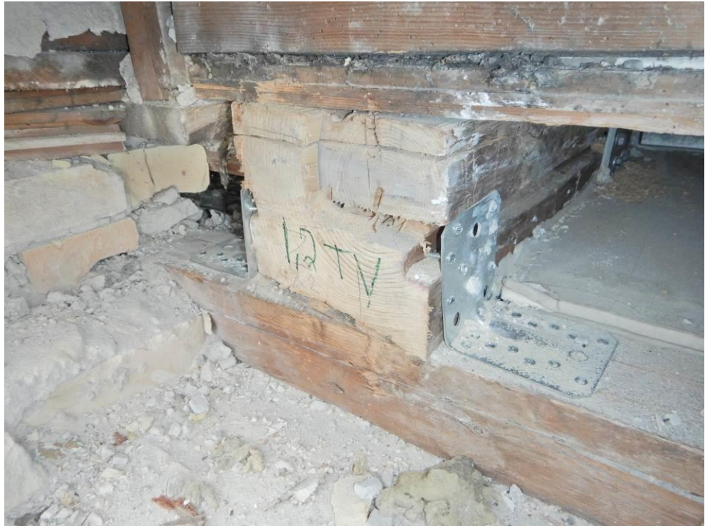
Foto 17: 2. sal. Ingen synlige tegn på nedbrydning i enden af bjælke B2.6 og underliggende bjælkerem.
