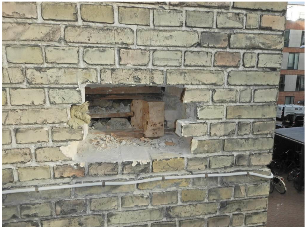
Foto 22: 1. sal. Åbning i ydervæg ind enden af bjælke B1.1.
