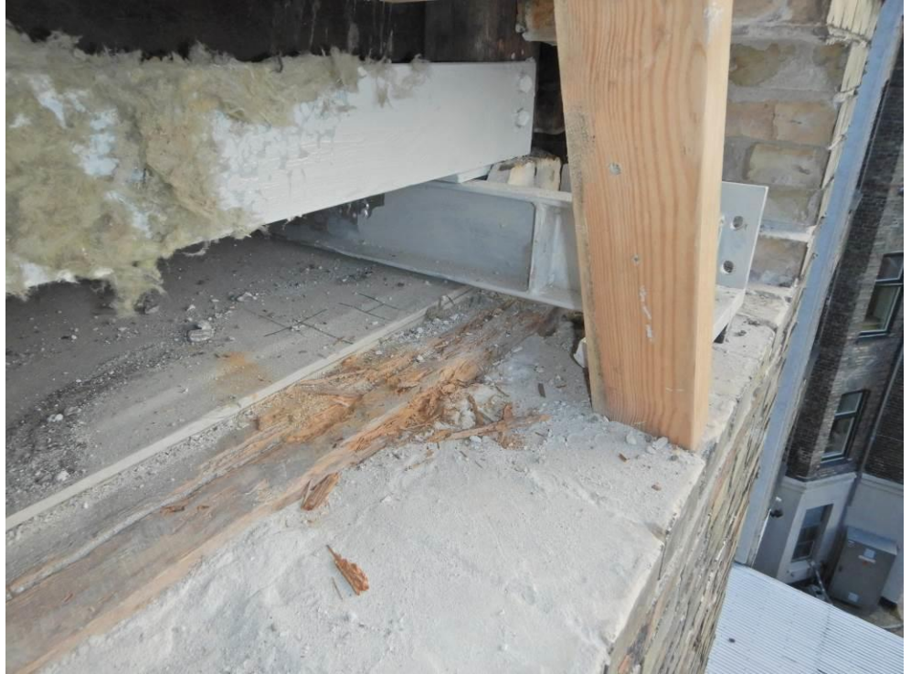
Foto 7: 3. sal. Konstateret lettere nedbrydning i bjælkerem mellem bjælke B3.1 og B3.2.
