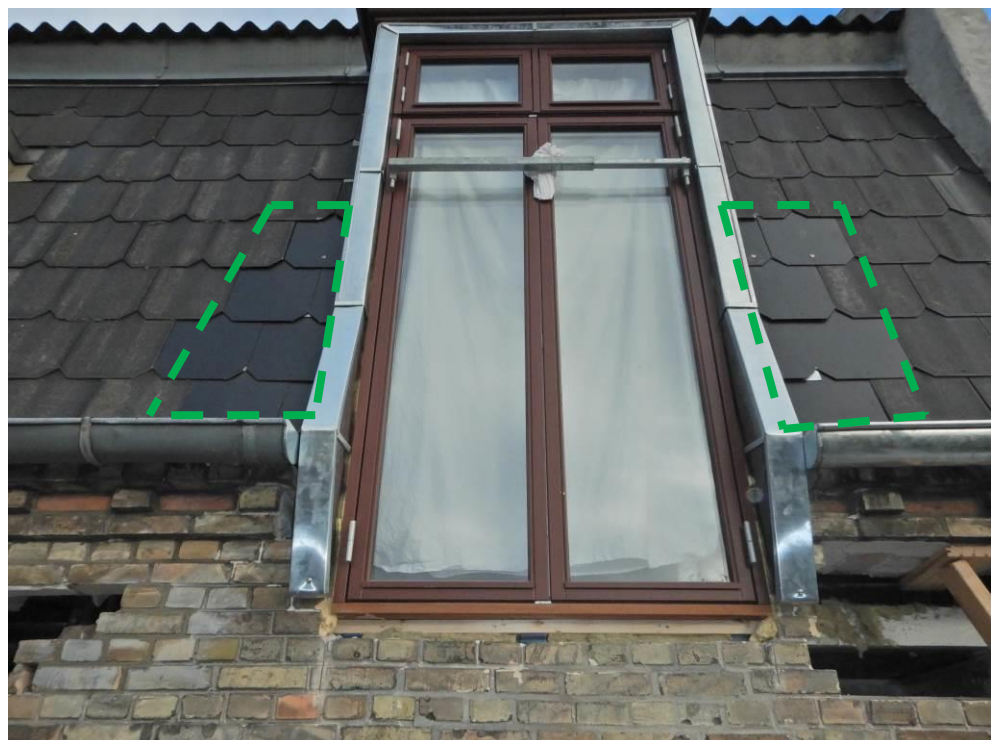
Foto 2: 4. sal: Bjælkelag med angreb af Ægte Hussvamp.
