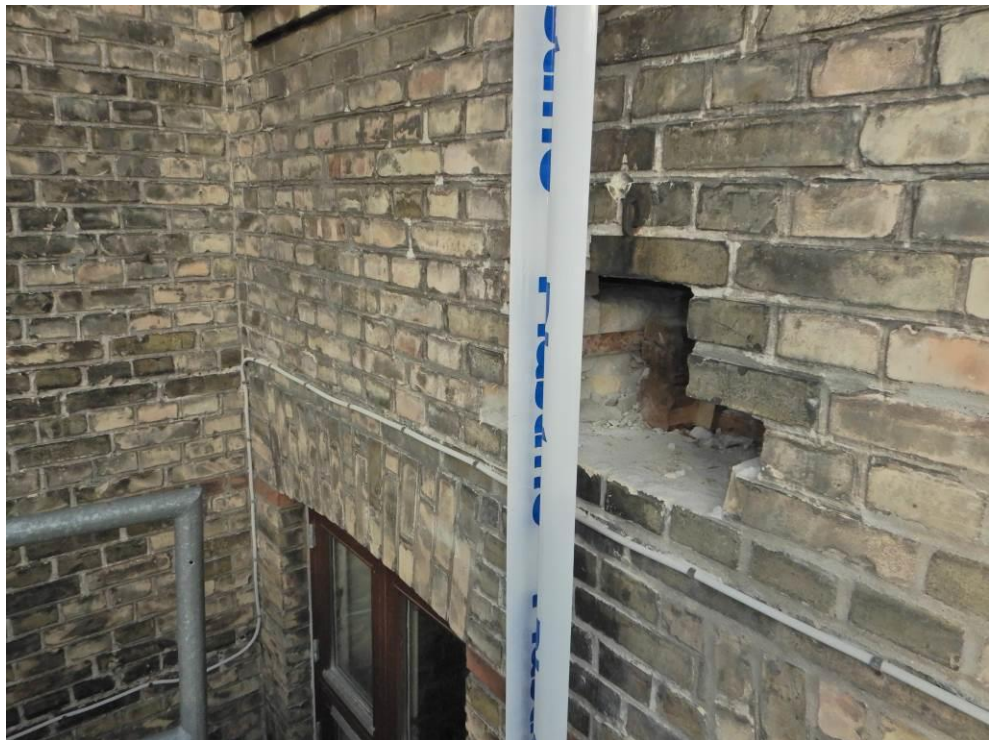
Foto 24: 1. sal. Åbning i ydervæg ind enden af bjælke B1.6.
