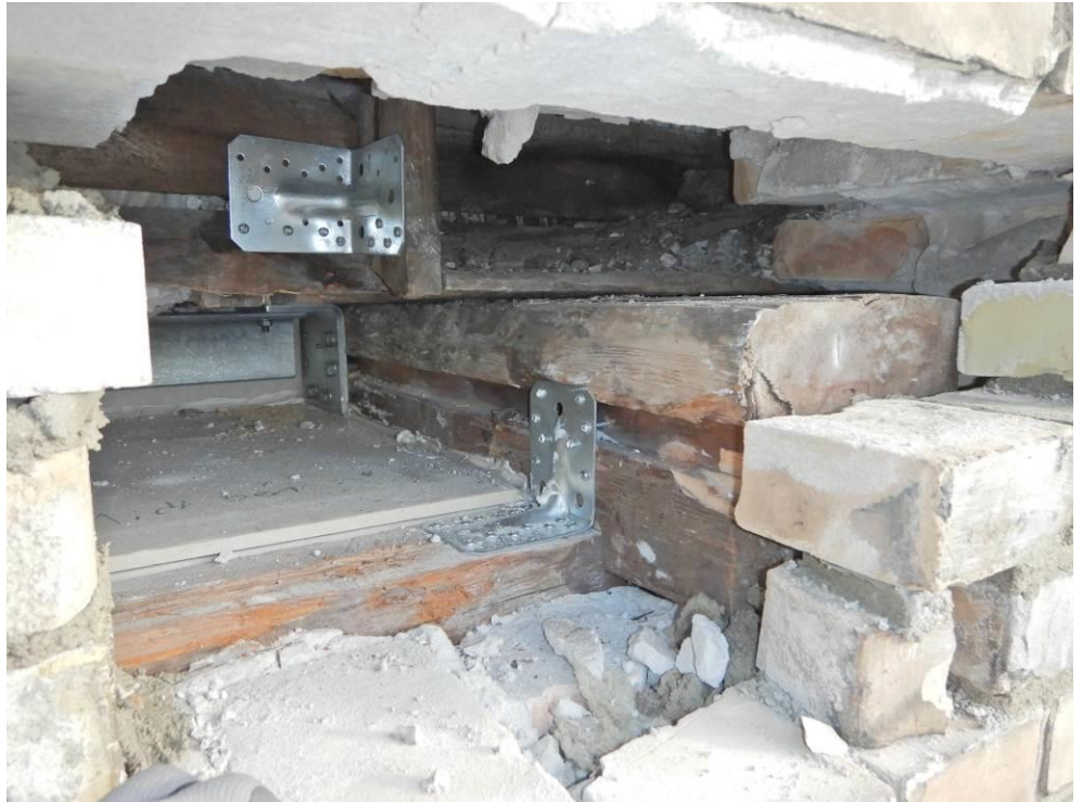
Foto 11: 3. sal. Der blev konstateret lettere nedbrydning i bjælkerem mellem bjælke B3.4 og B3.5.
