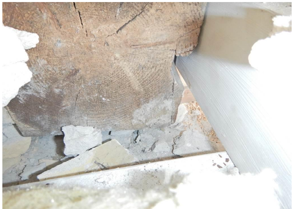
Foto 20: 2. sal. Overfladisk mycelievækst af Ægte Hus-svamp på enden bjælke B2.11. .
