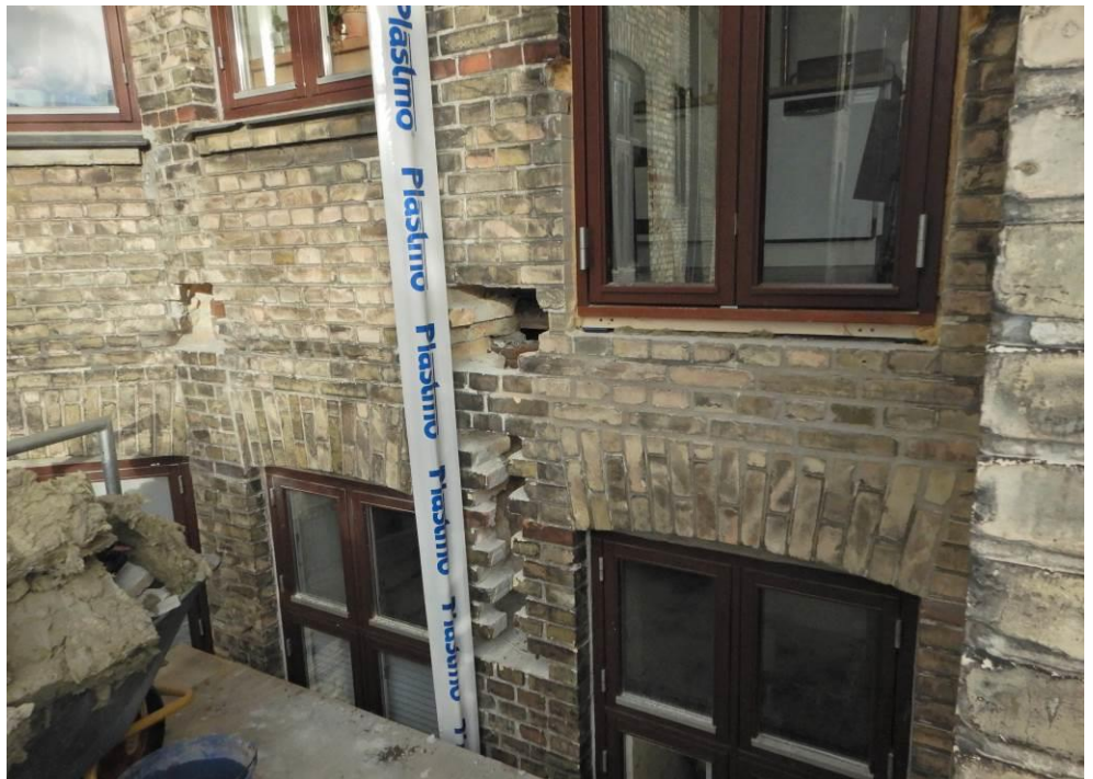
Foto 26: 1. sal. Åbninger i ydervæg ind til bjælkerem mellem B1.10 og B1.11, samt enden af bjælke B1.12.
