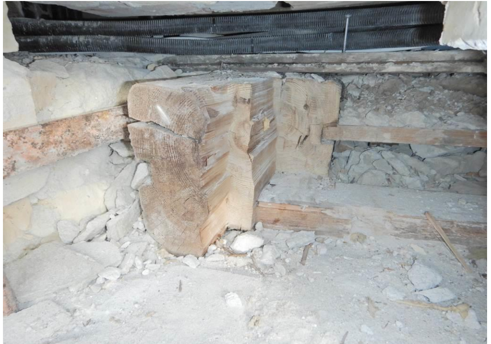
Foto 25: 1. sal. Enden af bjælke B1.6. Ingen nedbrydning i enden af bjælke B1.6 og underliggende bjælkerem.
