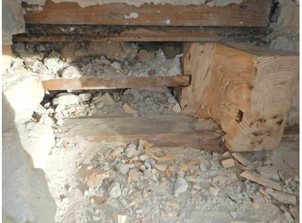
Foto 23: 1. sal. Enden af bjælke B1.1. Ingen nedbrydning i enden af bjælke B1.1 og underliggende bjælkerem.
