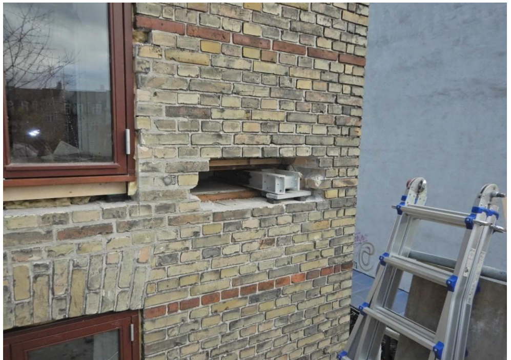
Foto 14: 2. sal. Åbning i ydervæg ind til enden af bjælke B2.1 og B2.2, samt underliggende bjælkerem.
